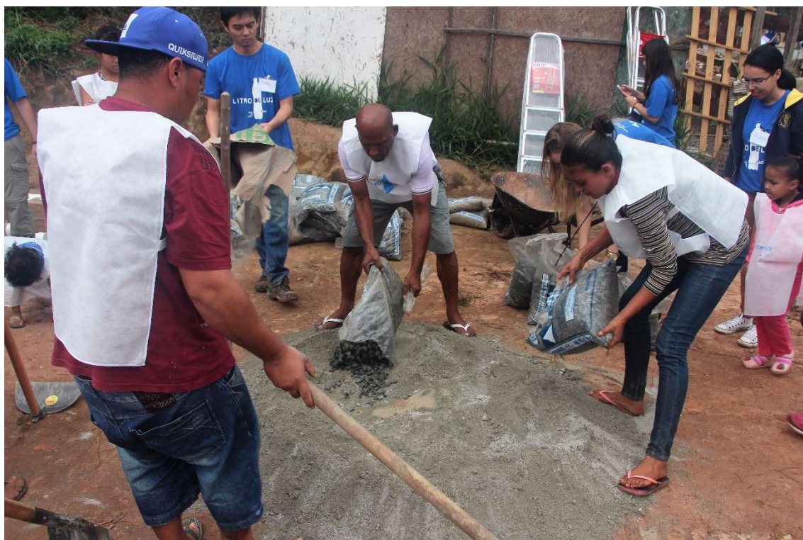
Figura 22 - Produção do concreto em campo
