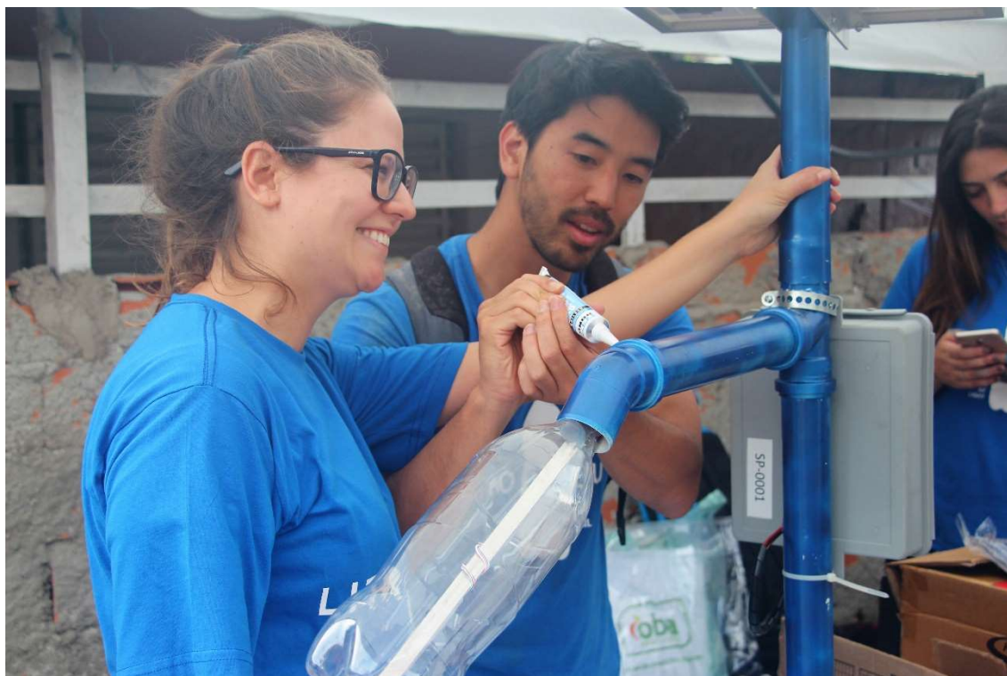
Figura 27 - Colagem e vedação dos componentes
