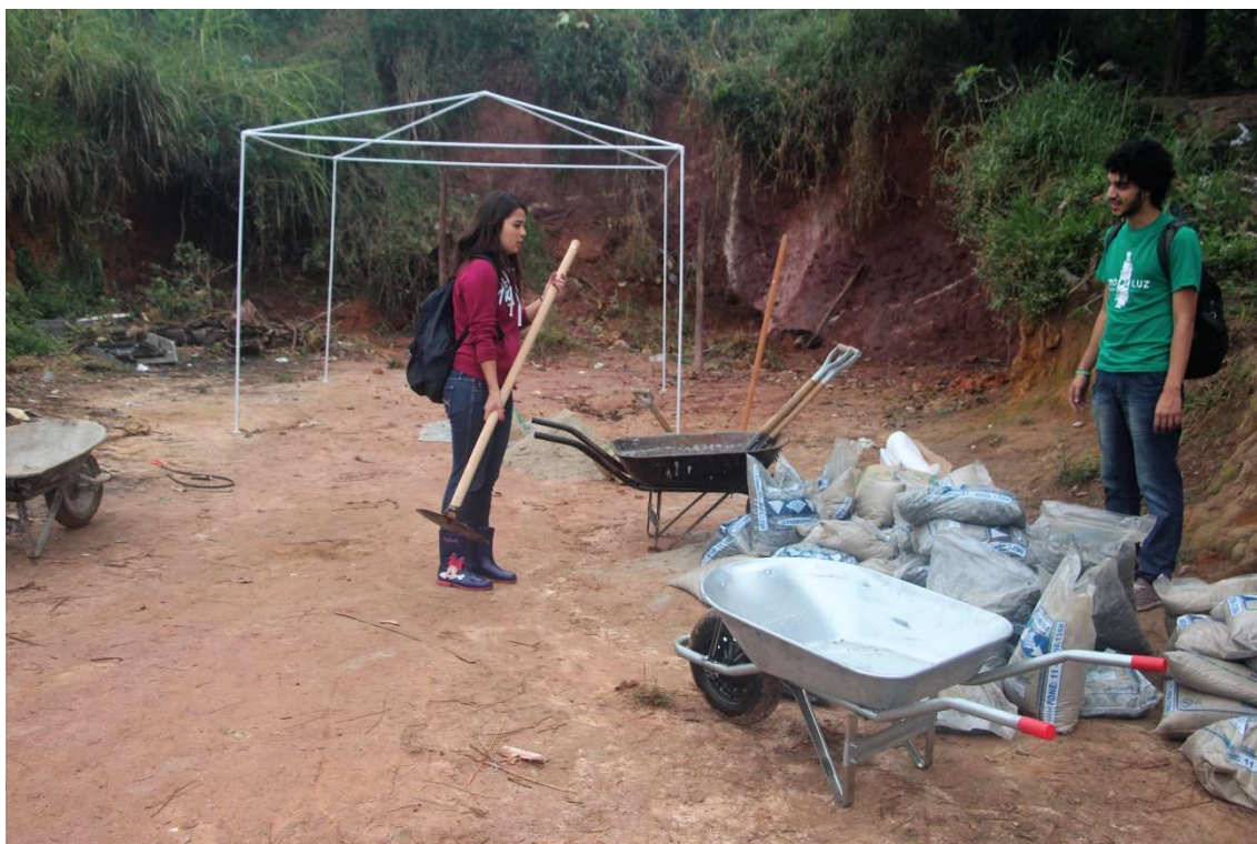
Figura 23 - Início da produção do concreto em campo
